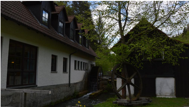
Die Kuchenmühle im Aufseßtal
